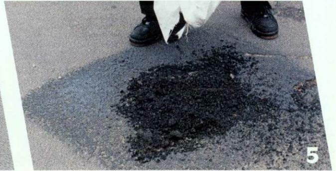
Rellenar utilizando C.A.R. aglomerado asfáltico caliente o mejor con asfalto C.A.R.
