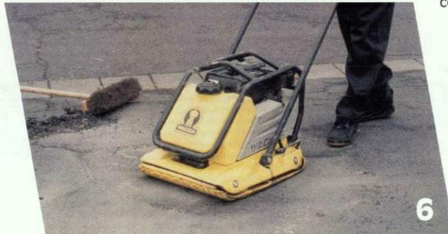
Compactar el asfalto con un rodillo o placa vibrante
